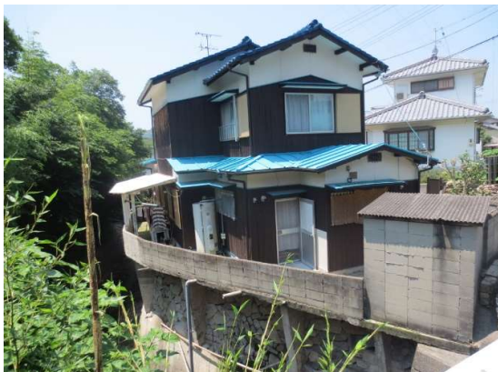
外観 川沿い側
