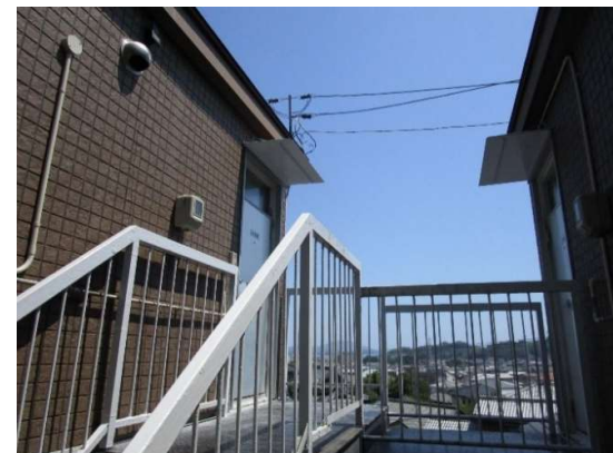
外部階段（玄関左手側）
