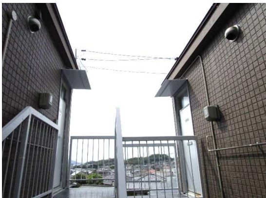
外部階段（玄関右手側）
