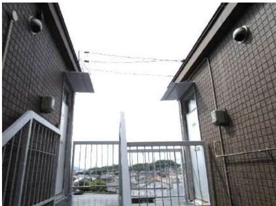
外部階段（玄関右手側）
