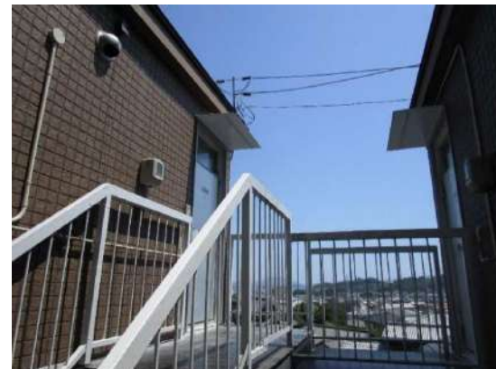
外部階段（玄関左手側）
